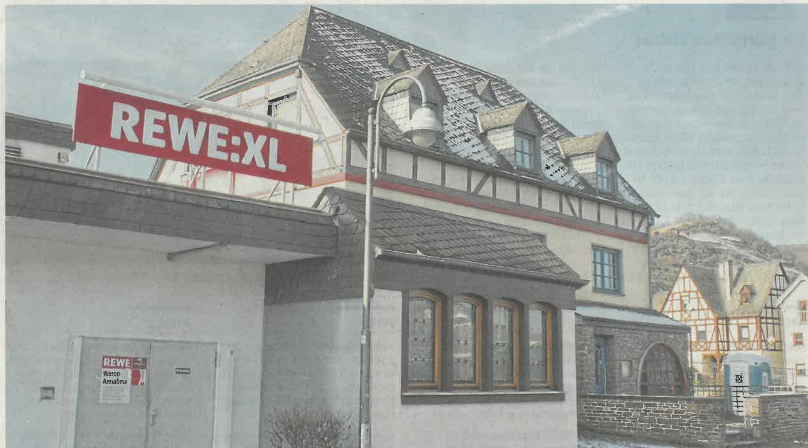
Der Rewe-Markt in Kobern-Gondorf soll erweitert werden. Um auf dem angrenzenden Grundstück Platz zu schaffen, wird bald auch das ehemalige Restaurant „Zum Weinfass“ (rechts) abgerissen.
