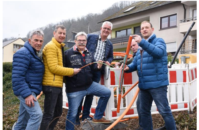
Bernhard Merkenich, Michael Dötsch, Josef Steiner, Matthias Reif und Uwe Riehl lassen sich von Thomas Sisterhenn erklären, wie die Glasfaser verlegt wird
